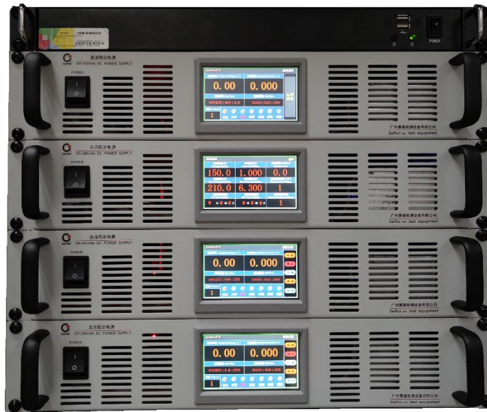
图 1.4. 电源仪器安装
